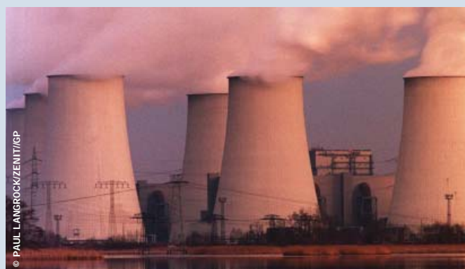
3000-MEGAWATT-KOHELEKRAFTWERK IN JAENSCHWALDE BEI COTTBUS. AUS DEN KÜHLTÜRME DIESER KRAFTWERKS DER SCHWEDISCHEN VATTENFALL EUROPE GMBH STEIGT DICHTER DAMPF AUF.
